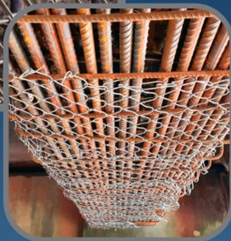
A Tela Galvânica G oferece garantia de dez anos contra qualquer processo de corrosão. Com uma semi-pilha comum você atesta os potenciais de corrosão antes da Tela G e os potenciais de proteção (zona de imunidade) após sua instalação.
