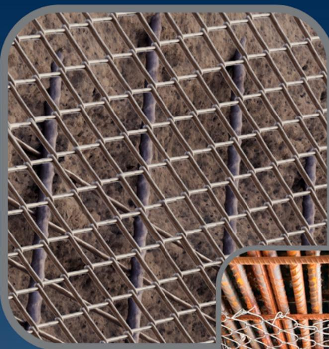
É a melhor solução contra a corrosão de armaduras em grandes áreas de estruturas de concreto armado ou protendido. Tela Galvânica é a proteção catódica por corrente galvânica que lhe dá o melhor custo benefício em sua obra de recuperação motivada por corrosão.
